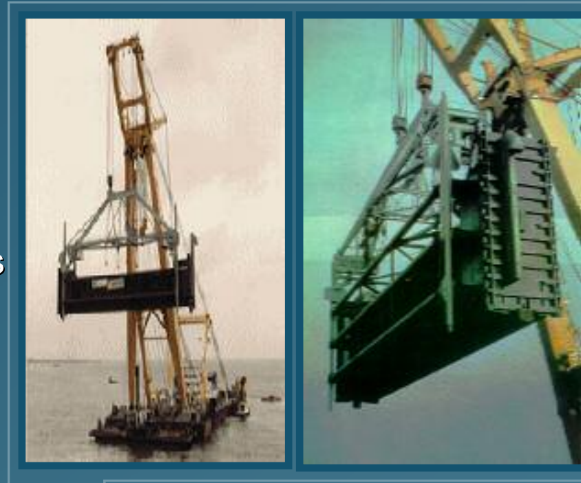
Inhangen schuif met Taklift
